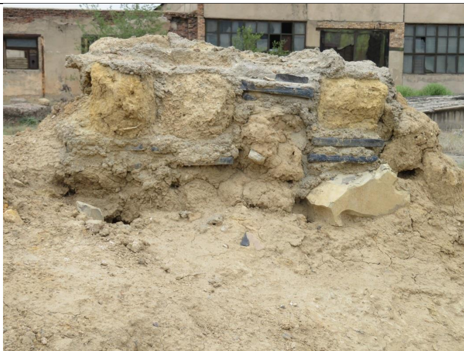
Ypatingojo lagerio Nr. 4 Kingyre, III-ojo skyriaus tvoros, skyrusios vyrų ir moterų punktus, liekanos. Tvora- siena mūryta iš prastai išdegtų ir nedegtų molio plytų. Viena juodos spalvos išdegta plyta paimta iš šios sienos ir perduota LGGRTC muziejui. Vaizdas iš vyrų punkto pusės. (L. Kvizikevičiaus nuotr., 2017-07-11).
